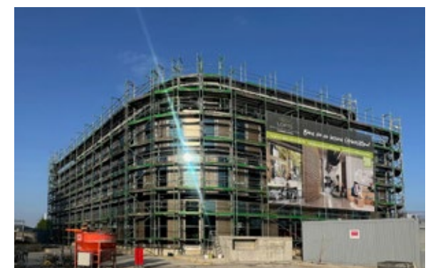
April 2024: Rohbau Haus 1 steht. © brixx projektentwicklung GmbH/LeitWerk AG
