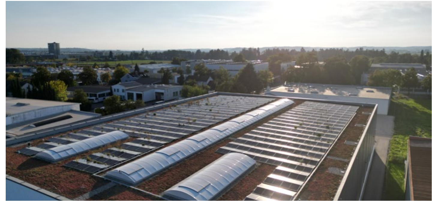
Das 2021 fertiggestellte Logistikzentrum der Eduard Lutz Schrauben-Werkzeuge GmbH mit 788 PV-Modulen Bild: © Christian Zärle
