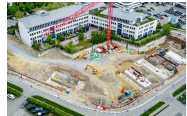
Mai 2023: zwei große Eis-Sole-Speicher sind zu erkennen. © brixx projektentwicklung GmbH/LeitWerk AG
