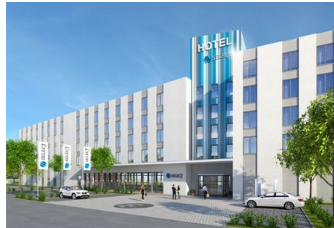
Das NOVUM Hotel im GVZ Region Augsburg ist bereits kurz vor Fertigstellung. Bilder: ESER REAL ESTATE GmbH & Co. KG
