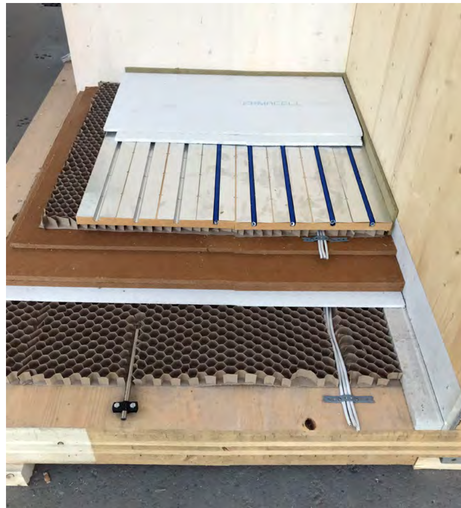
rechts: Der Cradle-to-Cradle-Fußboden ist durch die Wabenstruktur, die mit Beschwerungsmaterial ausgefüllt ist, komplett rückbaubar. Bild: Kaden + Lager
