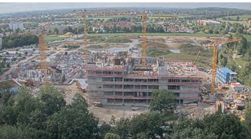
Baustellenkamera des Staatlichen Bauamtes Augsburg mit Blick auf den zukünftigen Medizincampus der Universität Augsburg. Bild: Staatliches Bauamt Augsburg
