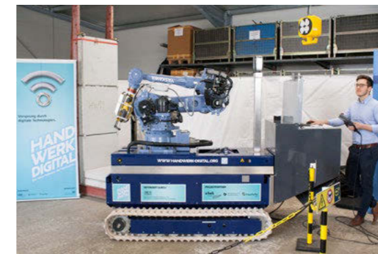
Kettenfahrwerk mit montierter Scherenhubbühne erleichtert Über-Kopf-Bohren. Bild: Fraunhofer IGCV
