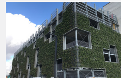
Parkhaus mit begrünter Fassade
